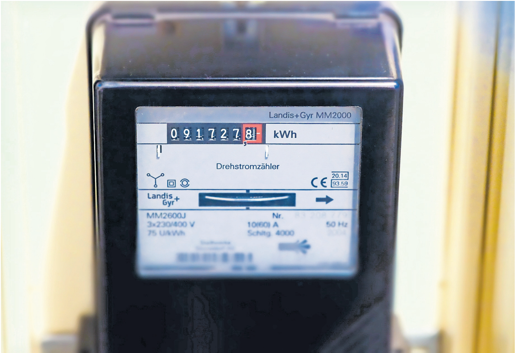
Analoge Drehstromzähler können den Stromverbrauch nur als Summe messen, nicht zeitlich zugeordnet.
