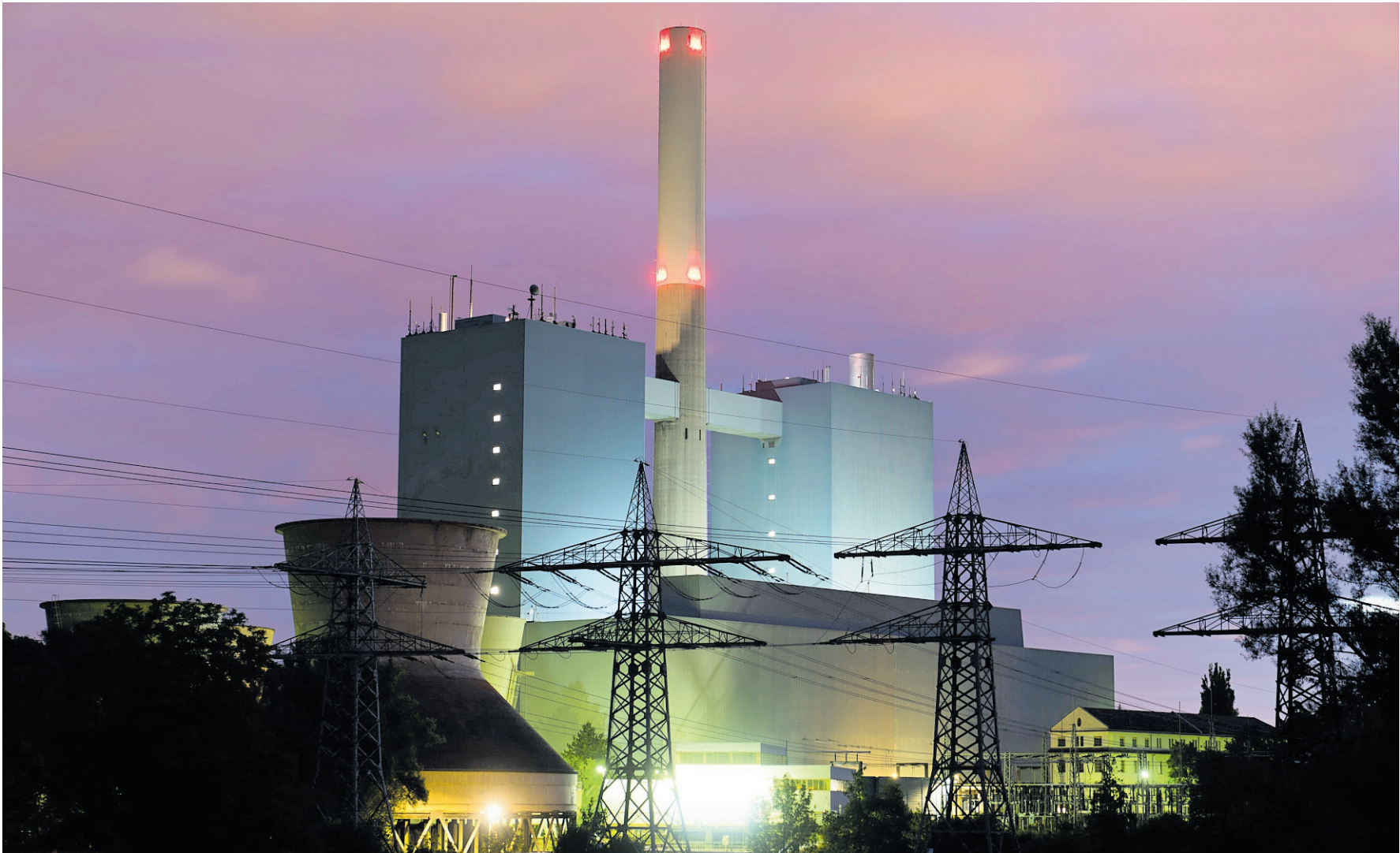
Blaue Stunde über dem Uniper-Gaskraftwerk in Gebersdorf.
