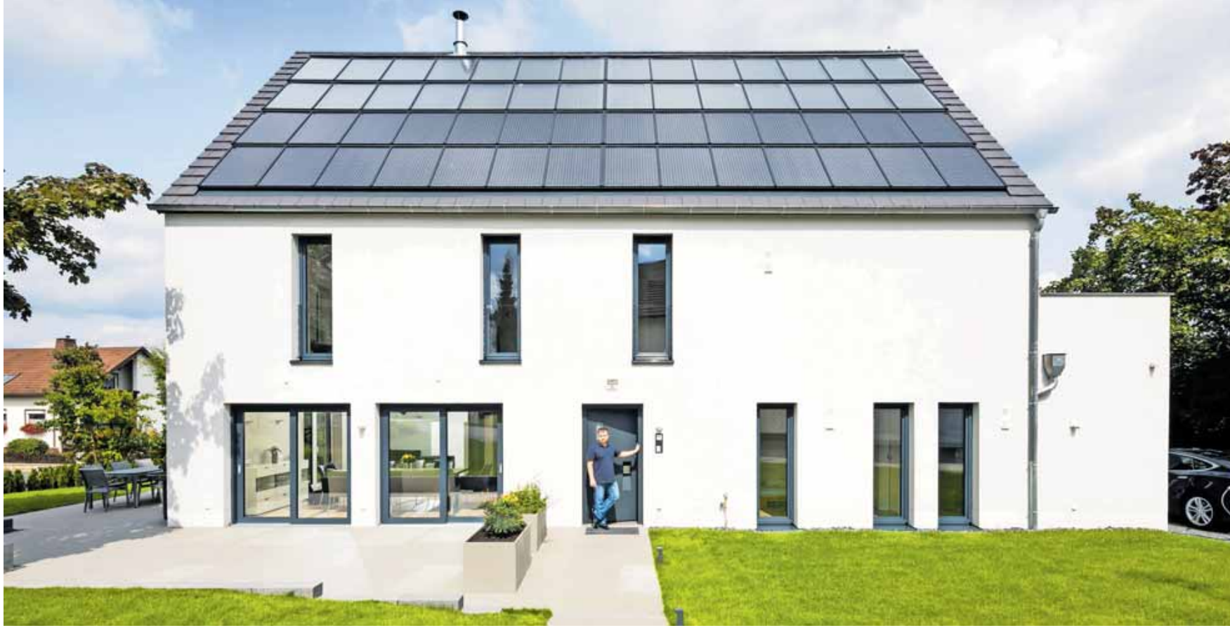
Das Haus als Kraftwerk: Drei Viertel des Bedarfs an Heizenergie deckt Matthias Gemeinhardt mit Solarthermie. FOTO: UDO GEISLER / GEMEINHARDT AG / SONNENHAUS-INSTITUT
