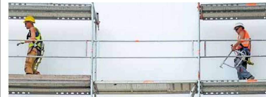
Vor allem in den Sechziger- und Siebzigerjahren sind in vielen Gemeinden neue Wohnsiedlungen entstanden. Die Häuser müssen nun saniert werden. FOTO: DPA
